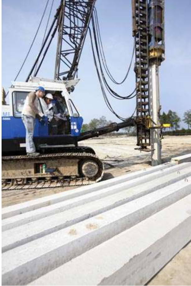
NAM-directeur Roelf Venhuizen slaat onder begeleiding de eerste paal voor de WKC/OBI
